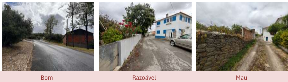
Figura 26. Exemplos do estado de conservação dos espaços de circulação da ARU
