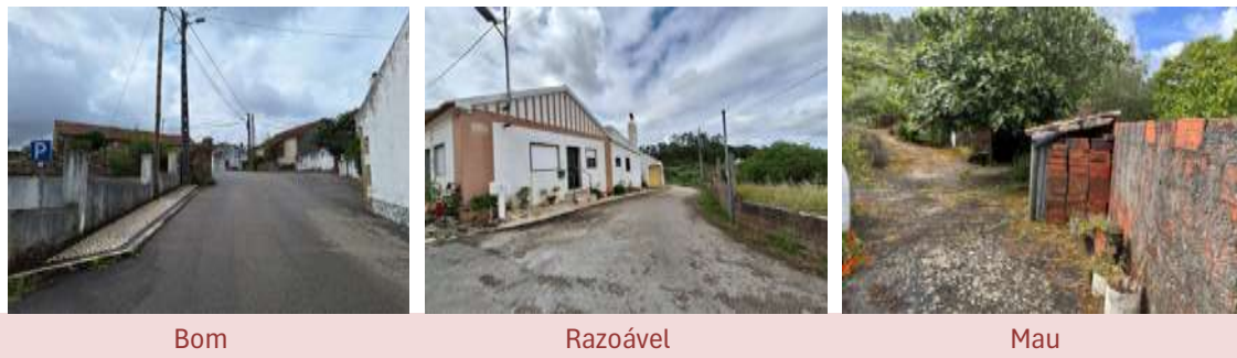
Figura 12. Exemplos de espaços públicos de circulação na ARU de acordo com o seu estado de conservação
