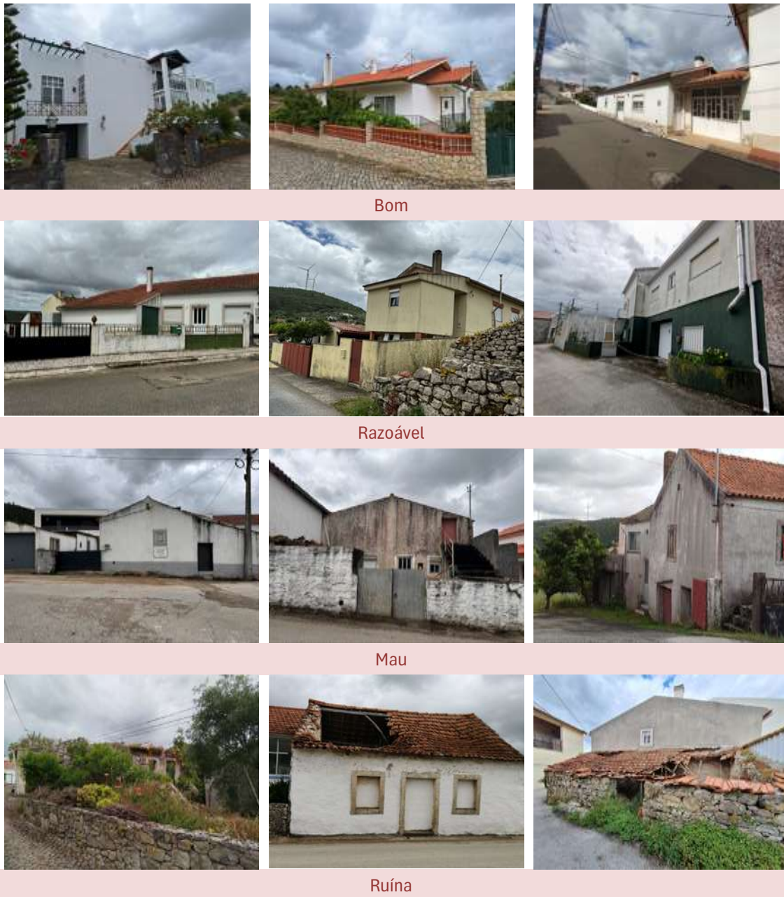
Figura 11. Exemplos de edifícios presentes na ARU de acordo com o seu estado de conservação
