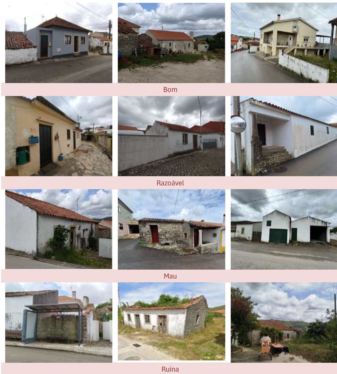
Figura 15. Exemplos de diferentes estados de conservação do edificado da ARU
