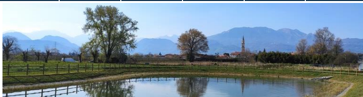
Figura 15. Medida de drenagem sustentável: Bacia de retenção
